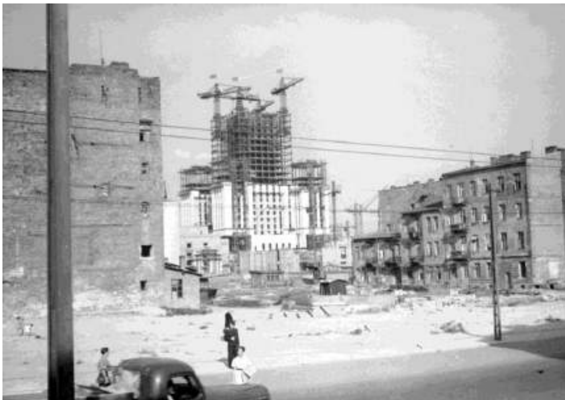
Ilustracja 36. Budowa Pałacu Kultury i Nauki, 1953 r., fot. W. Tuszko 1144 .
