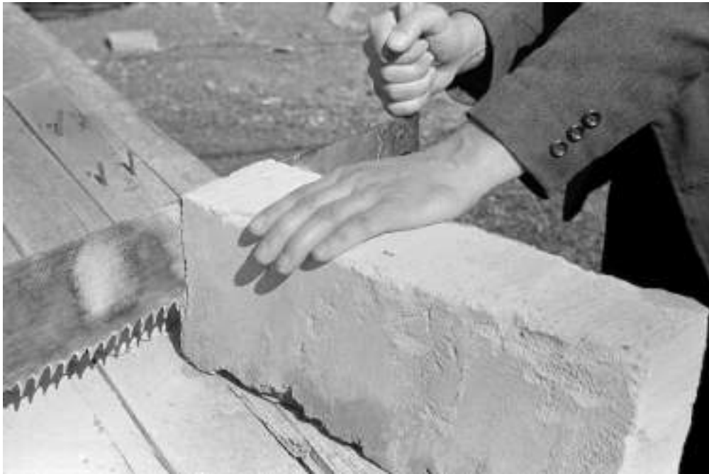
Ilustracja 3. Prezentacja przycinania bloczka gazobetonowego; zdjęcie wykonane w zakładzie prefabrykacji w Tychach, ok. 1959. Fot. Zygmunt Kubski, ze zbiorów Muzeum Miejskiego w Tychach 227 .
