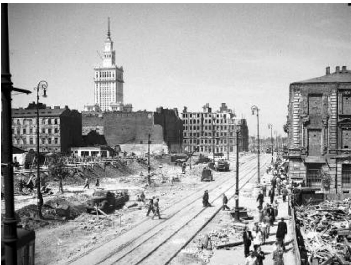
Ilustracja 37. Widok z wciąż zrujnowanej Marszałkowskiej w stronę budowanego Pałacu Kultury i Nauki i Alej Jerozolimskich - 1954 r., fot. Zbyszko Siemaszko 1145 .
