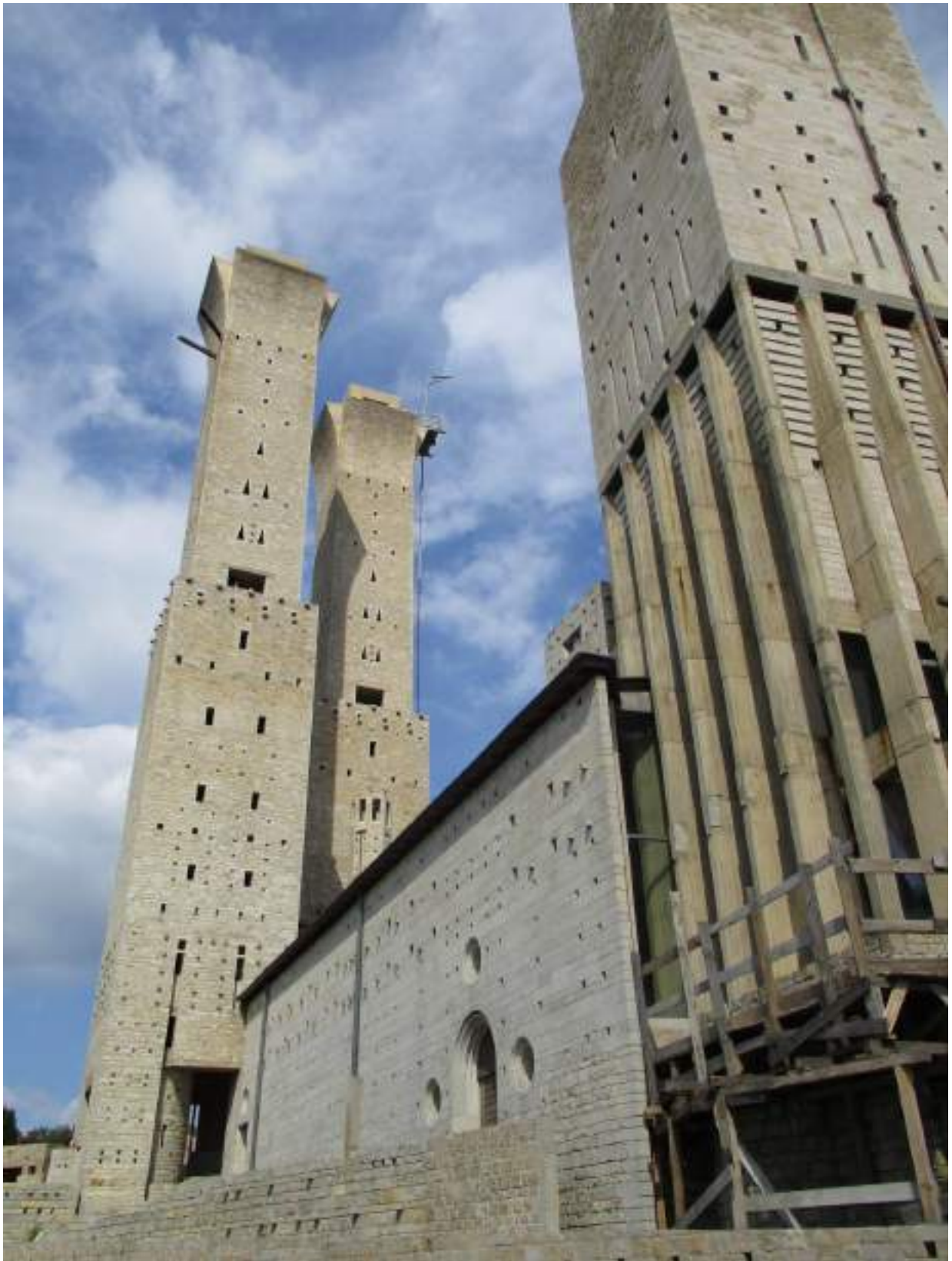
Kościół i klasztor pw. śś. Franciszka i Klary w Tydach, arch. S. Niemczyk, realizacja od 2000 r. Fot. E. Chudyba.
